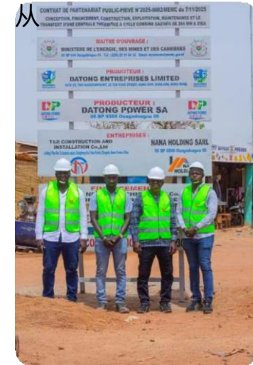
Le projet ZIGA a achevé les travaux de terrassement en mars 2026.
